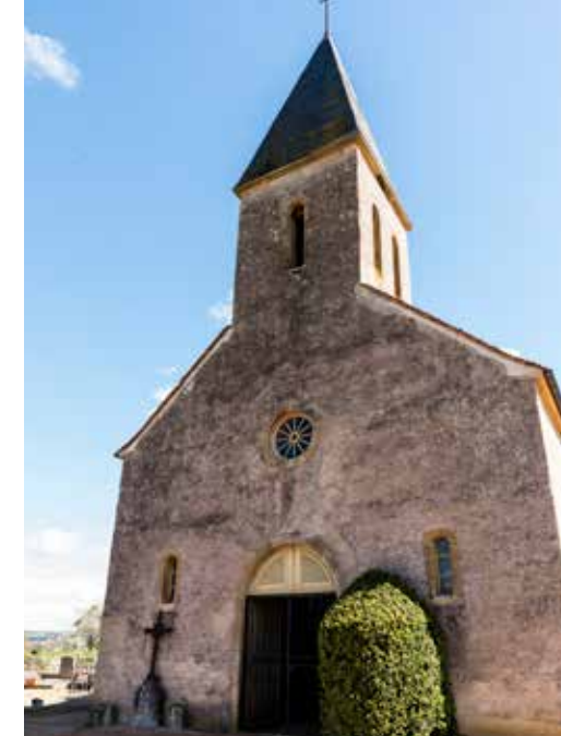
La façade de l'église de Vitry-lès-Cluny construite au XIX e siècle est simplement rythmée par quelques ouvertures.
